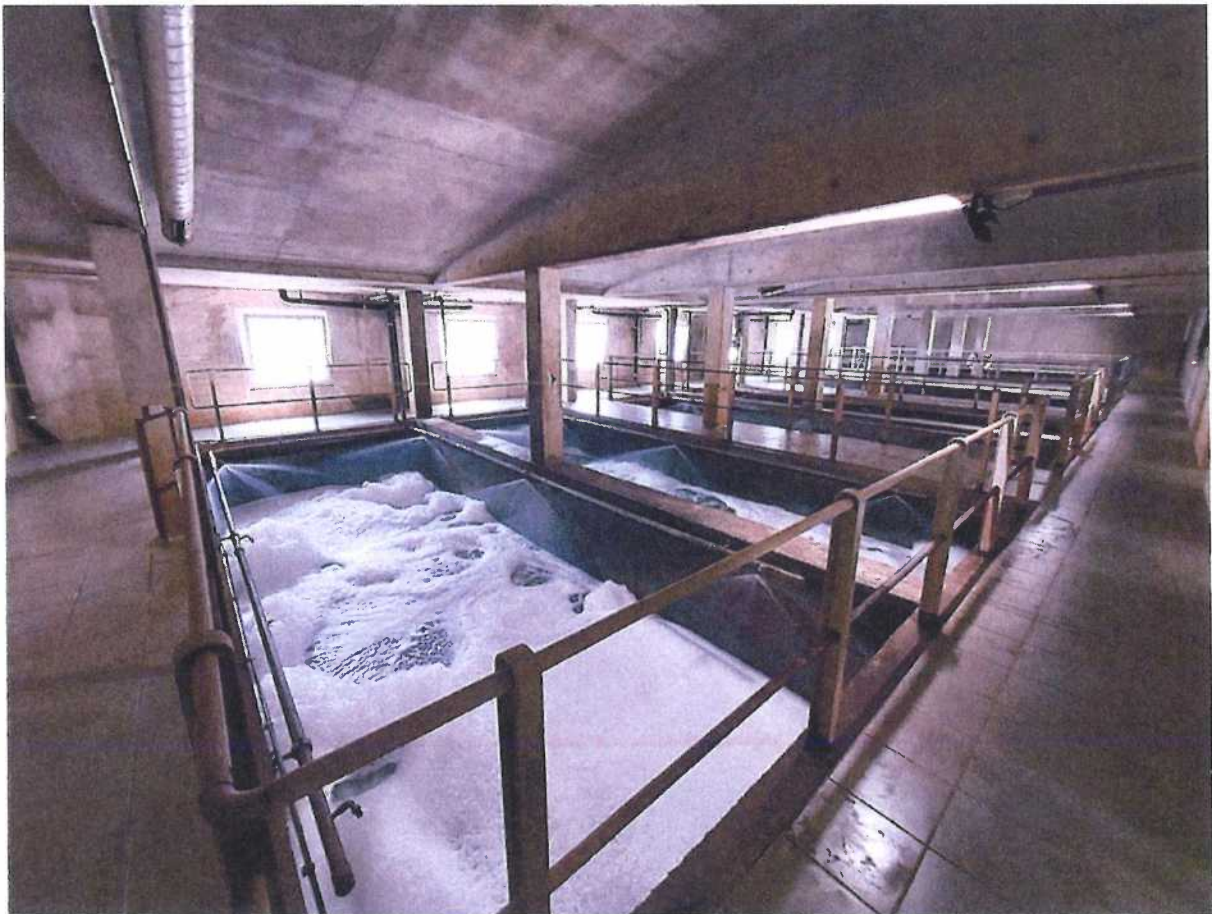
Figure 5 : Vue sur les Biopur© C avant assainissement.
