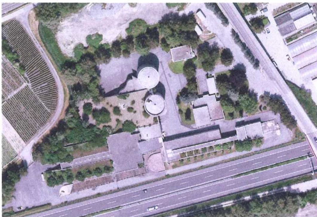
Figure 2 : Vue aérienne de la STEP au printemps 2021.
